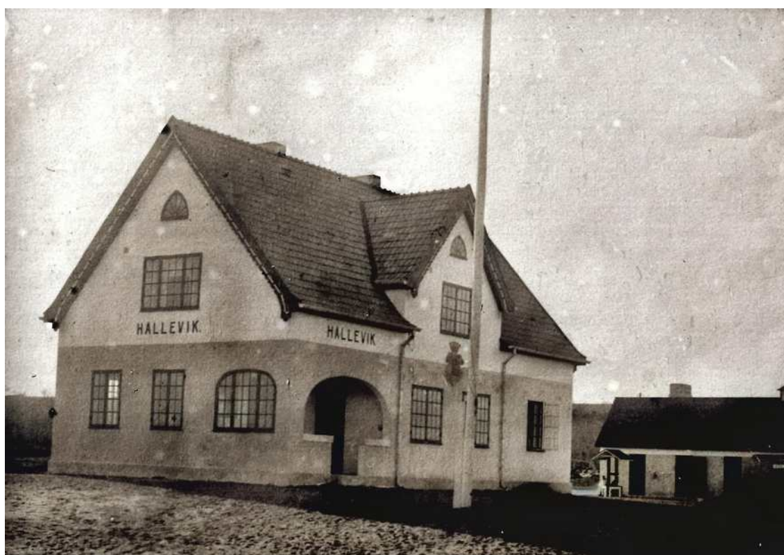
Hälleviks Station helt nybyggd. (Foto www.wingrens.se )
